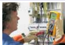
Test izolace na deskovém rozvaděči
